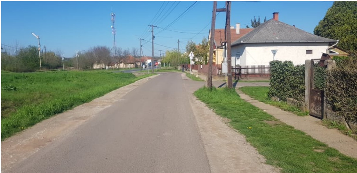
Felújítandó járdaburkolat a Vasút utcában
