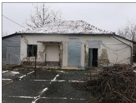
A vágóhíd épülete.
